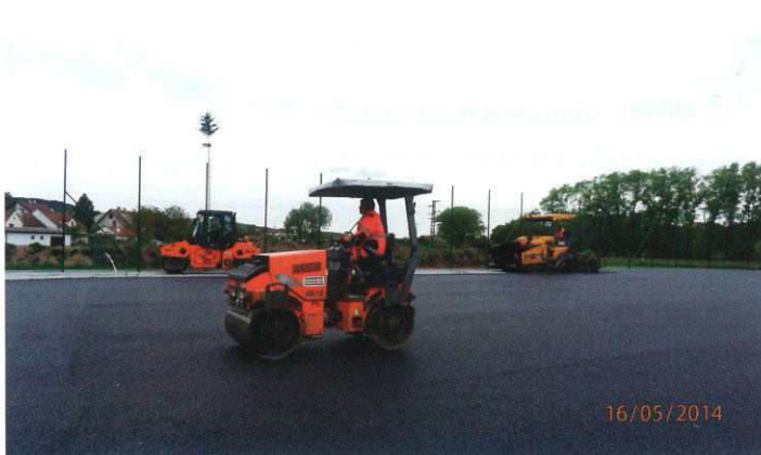
Podkladový asfalt se povedl
