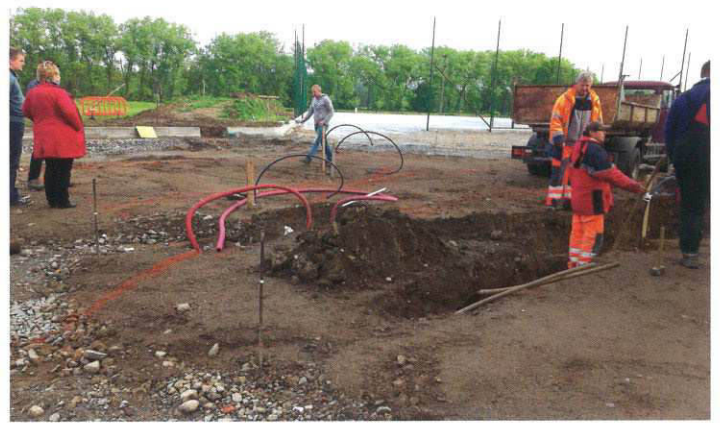
Pravidelně probíhají kontrolní dny na stavbě
