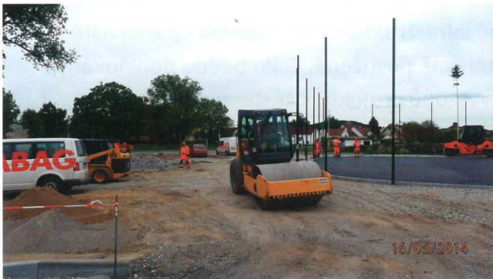
Stavba zdárně probíhá
